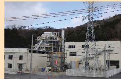
バイオマス発電所
